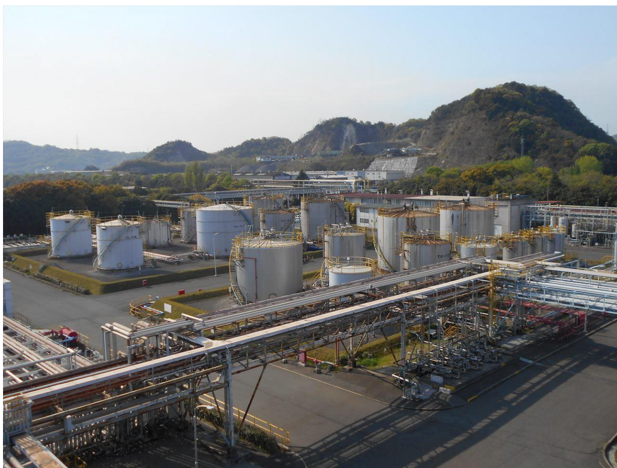
J F Eケミカル株式会社 西日本製造所笠岡工場 屋外タンク貯蔵所群
